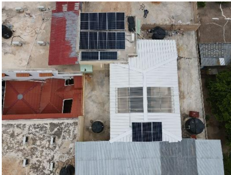
Instalación paneles solares Hotel Adelaida, Pedernales.
