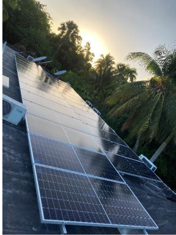
Instalación paneles solares Hotel Villas del Mar, Pedernales.
